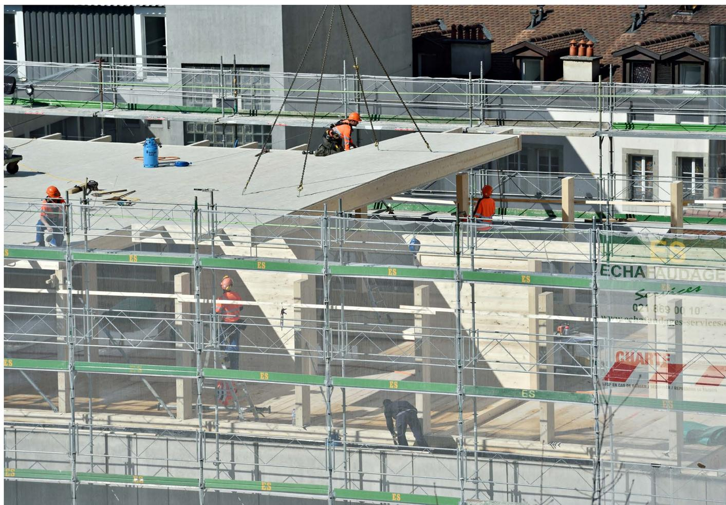
Le système mis au point par le LAST repose sur une structure en bois porteuse et des dalles à caissons tant pour les planchers que pour la toiture. Conçu sur les principes de la modularité et de la préfabrication, tout est pensé en fonction d'une haute qualité environnementale.
