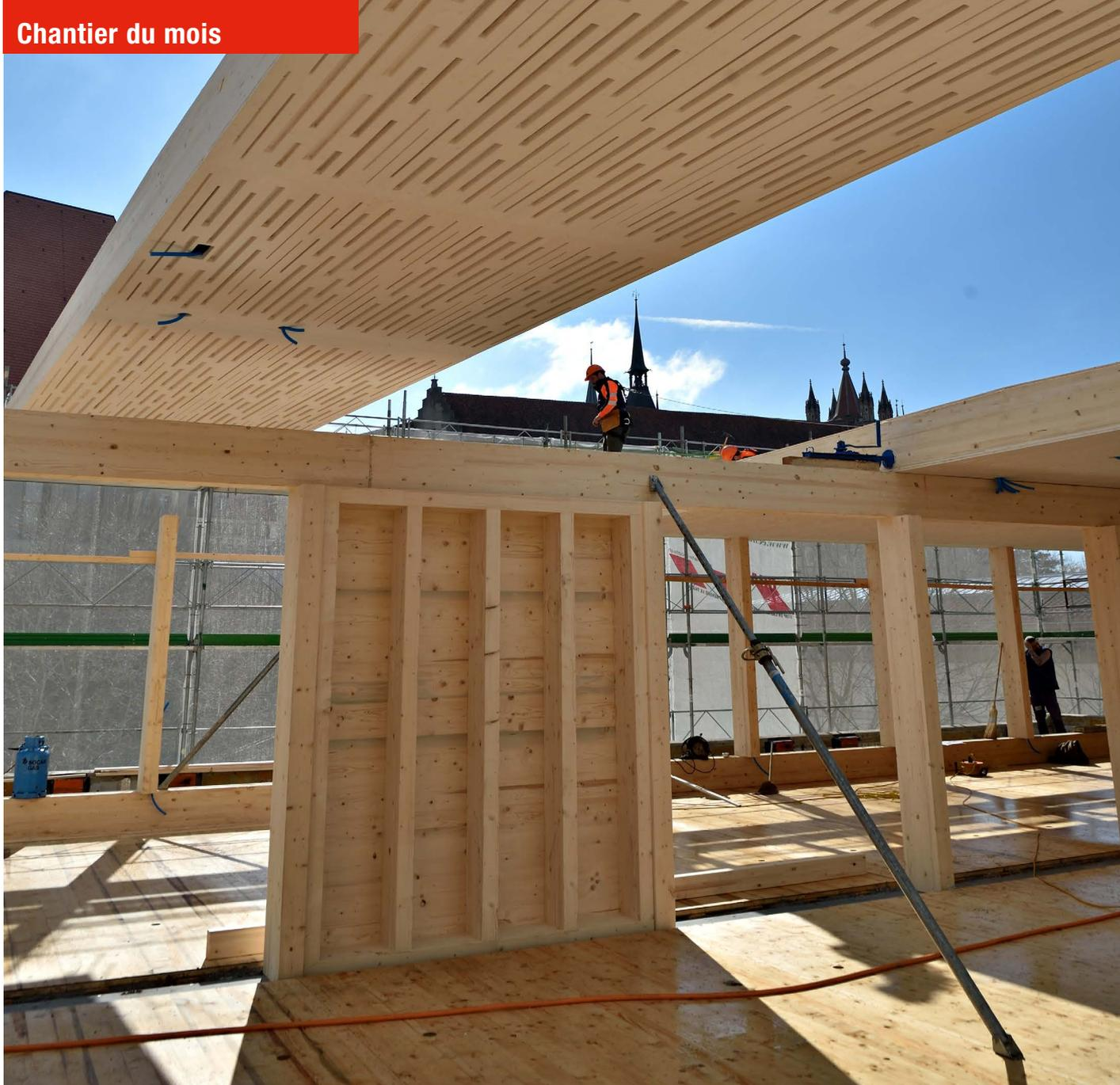
La travée centrale fait office d'ossature porteuse en bois. De part et d'autre, selon les désirs du client, il est possible d'aménager des bureaux individuels ou semi-ouverts, voire un vaste *open space*. Des contre-ventements antisismiques sont aménageables en espace de rangement ou coin machine à café...
