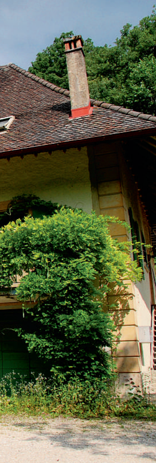
La toiture a été isolée avec de la ouate de cellulose recyclée. Les tuiles d'origine, faites à la main, ont été déposées, nettoyées et remises en œuvre sur place, tout en étant complétées par d'autres tuiles neuchâtelaises anciennes récupérées dans les alentours.
