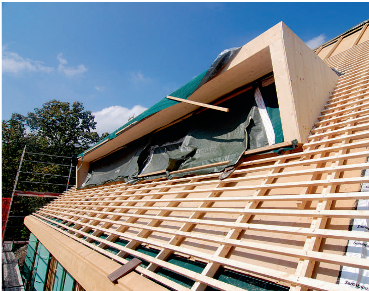
Le volume de la toiture a été rendu habitable par l'ajout d'une grande lucarne en bandeau.
