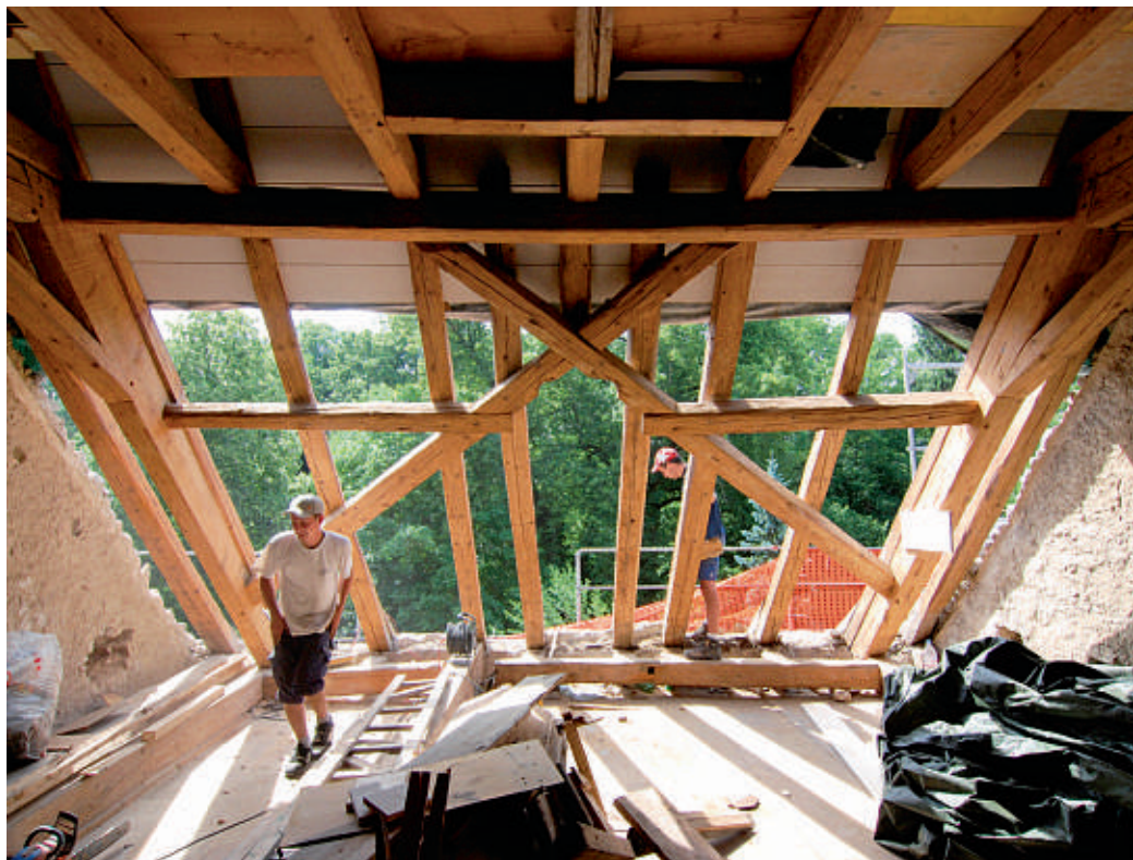
La toiture a été isolée avec de la ouate de cellulose recyclée. Les tuiles d'origine, faites à la main, ont été déposées, nettoyées et remises en œuvre sur place, tout en étant complétées par d'autres tuiles neuchâtelaises anciennes récupérées dans les alentours.
